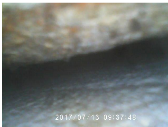
Fot. 23. Szczeliny na strychu sprawdzone za pomocą endoskopu-brak śladów bytowania nietoperzy.
