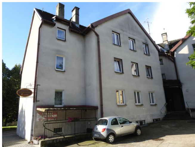
Fot. 5. Elewacja północno-zachodnia analizowanego budynku.
