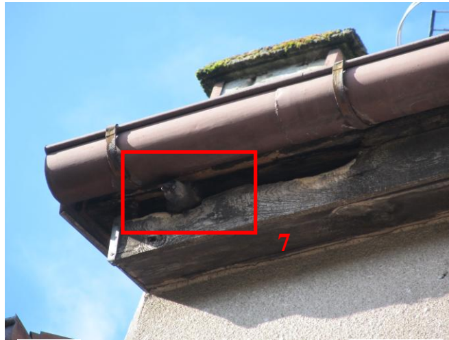
Fot. 16. Gniazdo kawki w deskowaniu dachu (kwadrat 7).
