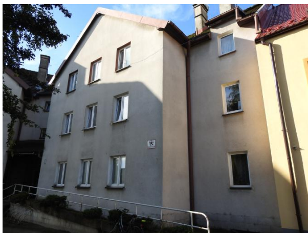
Fot. 4. Elewacja północna analizowanego budynku.
