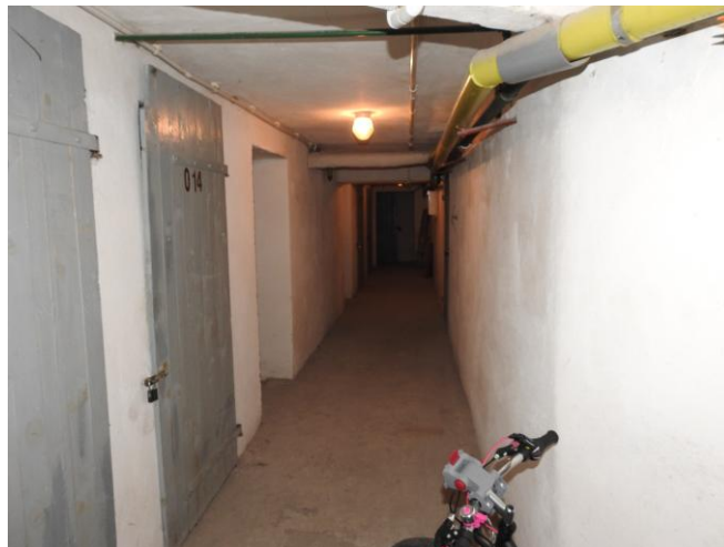
Fot. 24. Piwnica w analizowanym budynku wykorzystywana jako magazyn.
