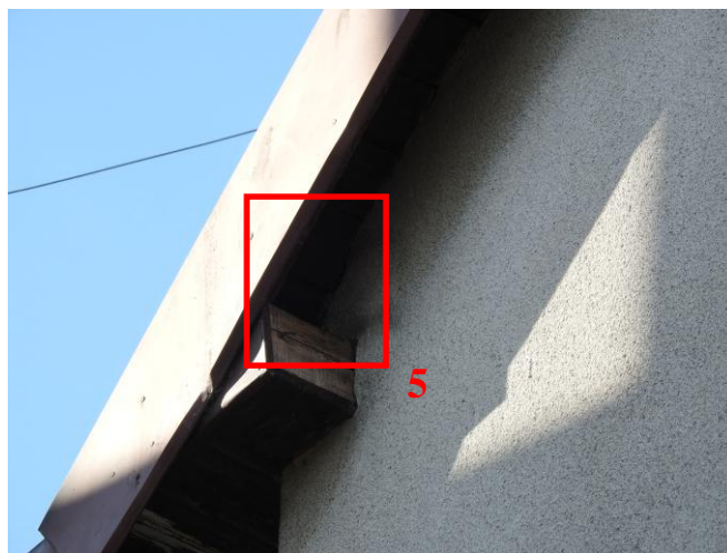
Fot. 14. Gniazdo kawki w deskowaniu dachu (kwadrat 5).
