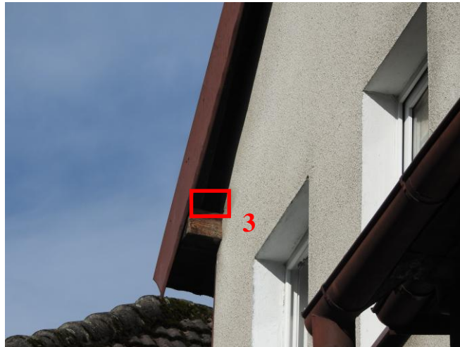
Fot. 10. Gniazdo kawki w deskowaniu dachu (kwadrat 3).
