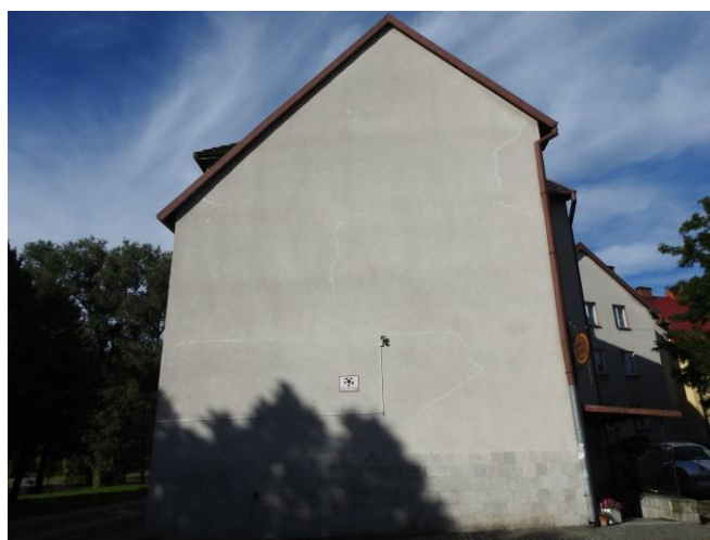
Fot. 6. Elewacja północno-wschodnia analizowanego budynku.
