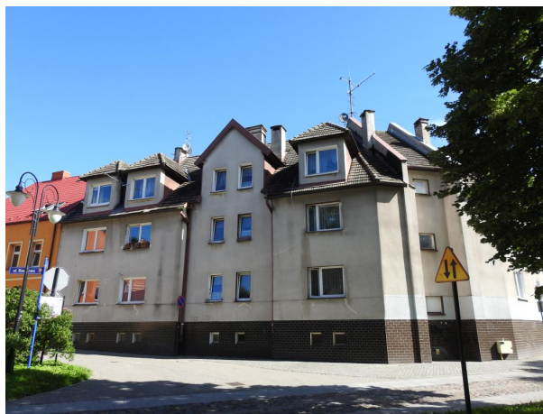
Fot. 3. Elewacja południowa analizowanego budynku.
