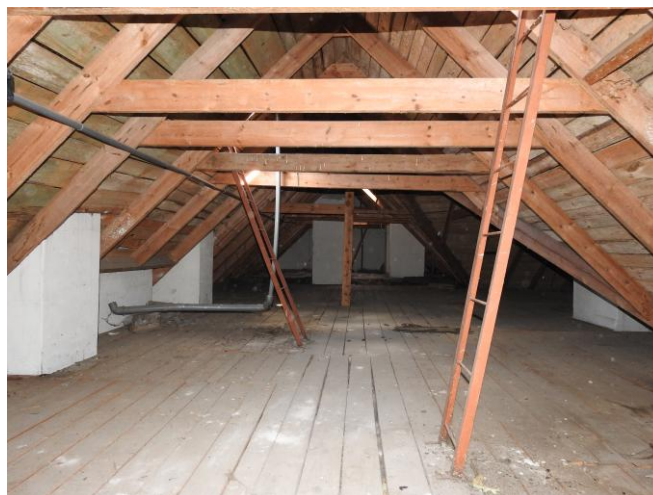
Fot. 22. Strych w analizowanym budynku.
