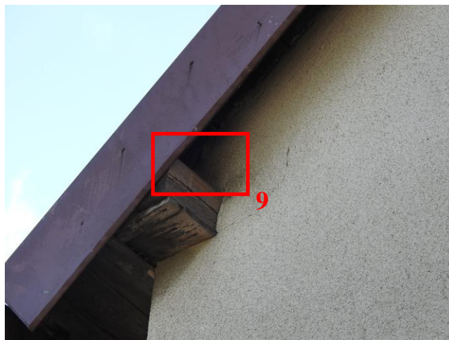
Fot. 19. Gniazdo kawki w deskowaniu dachu (kwadrat 9).
