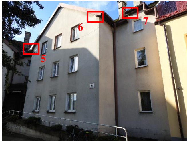
Fot. 13. Elewacja północna z zaznaczonymi miejscami lęgowymi (5-7 kawka).
