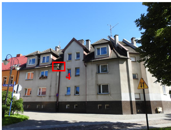
Fot. 11. Elewacja południowa z zaznaczonym miejscem lęgowym (4 gołąb miejski).
