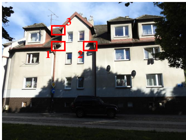
Fot. 7. Elewacja wschodnia z zaznaczonymi miejscami lęgowymi (1-2 gołąb miejski, 3 kawka).
